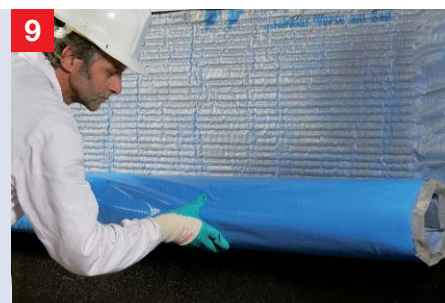
9 Schutz der trockenen Abdichtung Nach Durchtrocknung (zu prüfen an Referenzproben), die gesamte Abdichtung mit dem Remmers DS-Systemschutz schützen.
