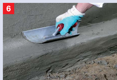
6 Dichtkehle mit Dichtspachtel Auch die Dichtkehle wird mit Remmers Dichtspachtel mittels der speziellen Dichtkehlkelle Frisch in Frisch eingebracht.
