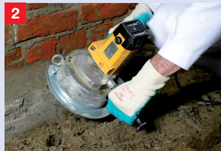
2 Reinigen des Fundamentbereichs Die Kante des Fundamentvorsprungs ist anzufassen. Haftungsmindernde Bestandteile sind vollständig zu entfernen – auch im Bereich der gesamten festsitzenden Altabdichtung.
