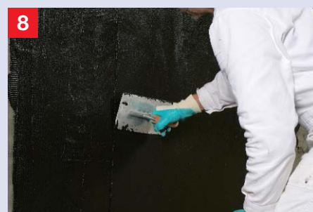
8 Auftrag der Bitumen Abdichtung mit Profi Baudicht 2K Nach Reaktion der Haftbrücke wird Remmers Profi Baudicht 2K oder einer anderen Remmers-KMB in zwei Arbeitsgängen aufgetragen.
