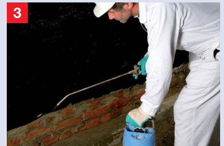
3 Grundierung mit Kiesol Die Grundierung mit Kiesol 1:1 mit Wasser wird mit einer Flächen-Spritze gleichmäßig aufgetragen. Stark saugende Untergründe sind mit Wasser vorzunässen.
