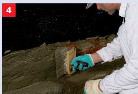
4 Haftbrücke mit Sulfatexschlämme Innerhalb der Kiesol-Reaktionszeit wird die Haftbrücke mit der Remmers Sulfatexschlämme aufgetragen.
