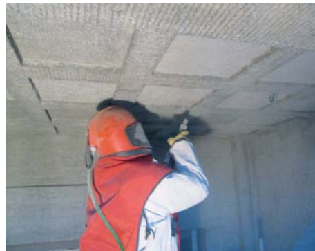
Sanftes Überstrahlen der reprofilierten Oberflächen zur Angleichung an den Bestand
