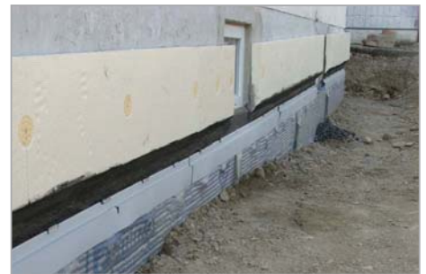
Fassadensockel mit Anschluss zwischen Abdichtung und Wärmedämmung
