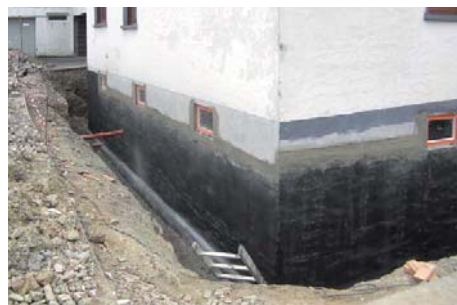
Untergroundvorbehandlung durch Auftrag von Dichtspachtel und einer Kratzspachtelung mit Multi-Baudicht 2K
