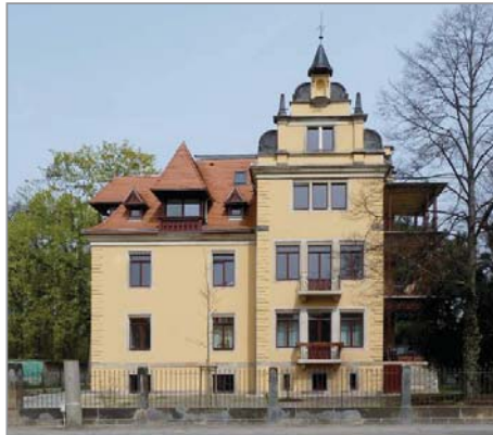
Sanierung der Gründerzeitvilla Loschwitz Str. in Dresden-Blasewitz
