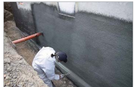
Nacharbeiten der Dichtkehle im frischen Zustand mit einem Heizkörperpinsel.
