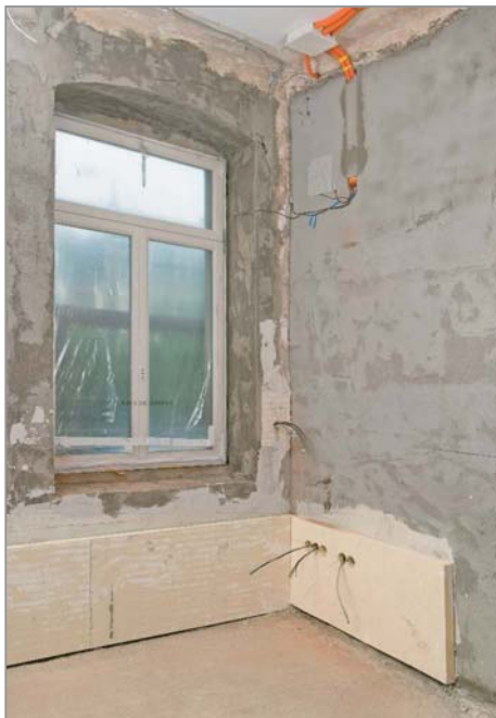
Messstelle 2: Position Südwestwand, Gebäudeecke u. Fensterleibung
