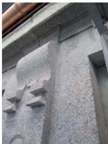
Abgeschlossene Schadenreparaturen und Reprofilierung mit Betofix RM
