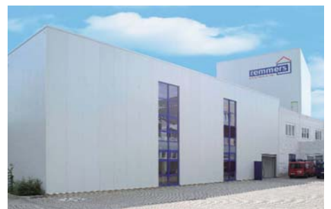
Neubau der Dispersionsfertigung in Lönningen
