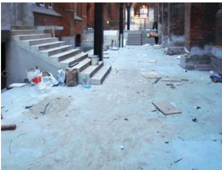
Abb. 2: Die Flächen vor der Untergrundvorbehandlung.
