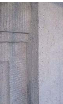
Restaurierte Ausbruchstelle nach steinmetzmäßiger Nachbehandlung (Scharierung) und Egalisierung durch sanftes Strahlen.
