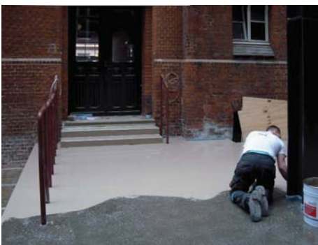
Abb. 4: Verlegung von PUR Uni Color
