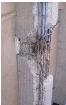
Freigelegte, korrodierte Bewehrungsseile eines Pilasters bis auf eine Tiefe von ca. 20 mm hinter dem Eisen.
