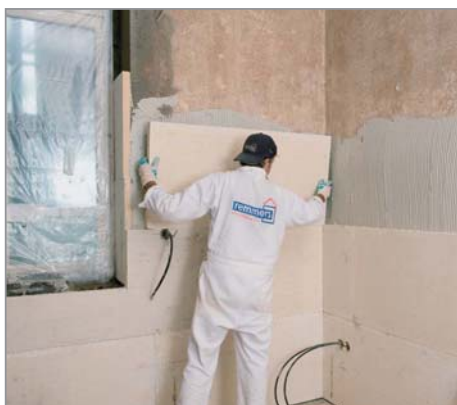
Einbau des iQ-Therm-Systems
