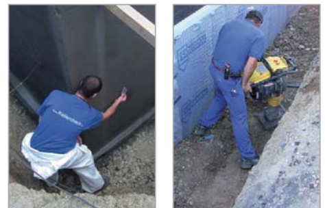
Messung der Frischschichtdicke von Multi-Baudicht 2K
