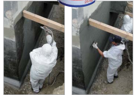
Auftrag in zwei Abdichtungsschichten
