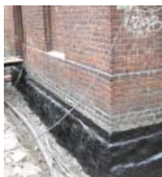
Hochdruckfest kunststoffmodifizierte Bitumenabdichtung mit Profi Baudicht. Hervorragend geeignet durch die Füllstofftechnologie mit Gummigranulat.
