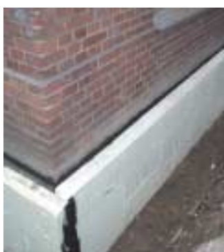
Schutz der Abdichtung und Wärmedämmung zugleich gewährleistet die vollflächige Verklebung der Styroporplatten mit Profi Baudicht.
